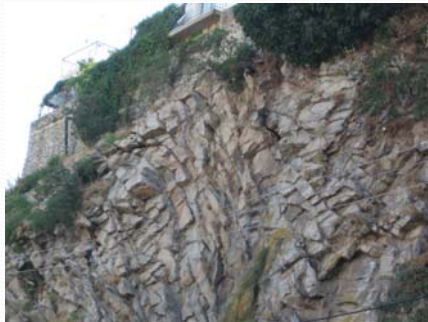
Κατακερματισμένη βραχομάζα γρανίτη σε πρηνές στην Καβάλα.
